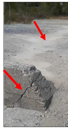
Indre bruplate før fornyelse. Gjennomgående sprekk på tvers av plata Sprekken over kanten Sprekk gjennom plata
